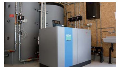
Der Technikraum mit Wärmepumpe und den beiden Warmwasserspeichern.
