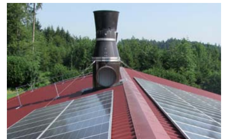
Einer der zwei Wärmetauscher (Reventa).
