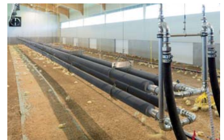
Die Rippenrohrheizung im Stall.
