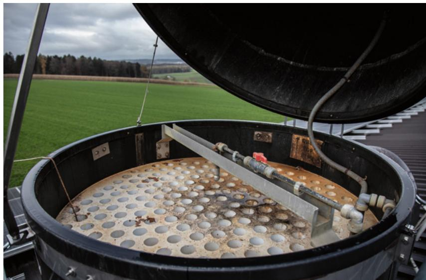
Blick in die geöffnete Wärmerückgewinnung auf dem Dach der Halle. Im Hintergrund die Photovoltaik-Anlage mit einer Leistung von 70 kWp.
