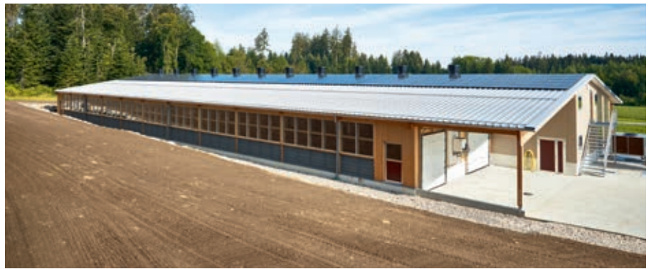
Aussenansicht des Stalls in Zimmerwald mit PV-Dachanlage und verglastem Wintergarten. Rechts neben der Treppe sind Teile der Luft-Wasser-Wärmepumpe zu sehen. Bild: Bell
