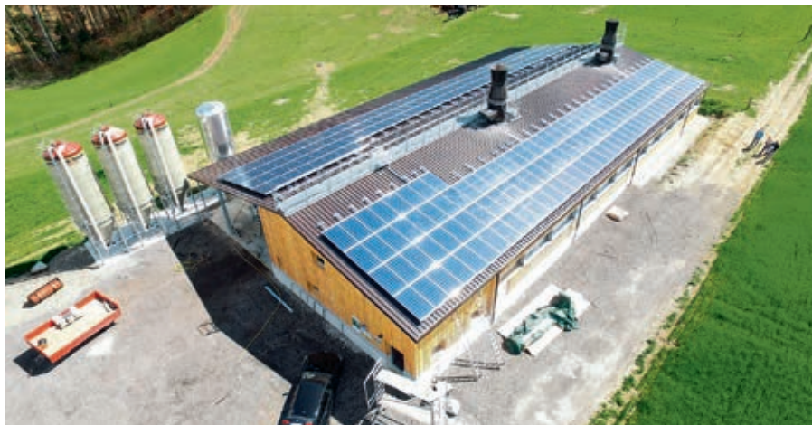
Der Micarna-Maststall in Hellsau: Zwischen den Modulen der Photovoltaik-Anlage sind die beiden Rohrbündelwärmetauscher zu sehen, links neben den Futtersilos ist der Wärmespeicher. Für die Wärmepumpe wurden 2800 m Soleleitungen verlegt. Bild: BFE
