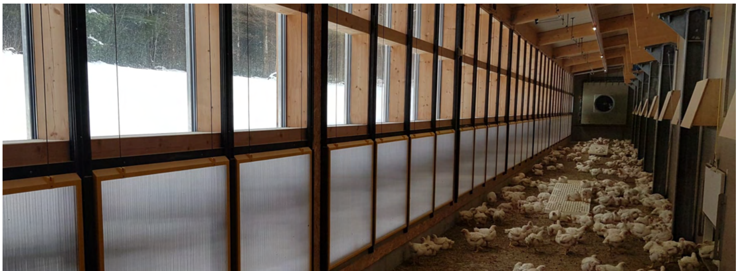
Pouletstall in Zimmerwald (BE): Bei kalten Temperaturen sind die Schieber des Wintergartens geschlossen. Ganz hinten sieht man den Zuluftwärmetauscher, womit durch das KVS immer frische, vortemperierte Luft in den Wintergarten gelangt. Foto: BZG Guggisberg und Nussbaum
