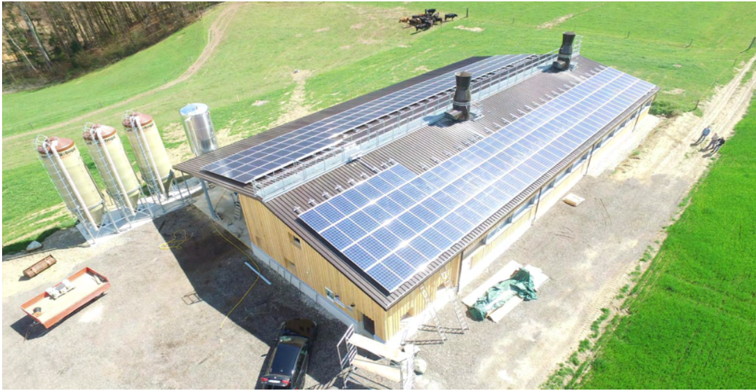
Der Micarna-Maststall in Hellsau (BE): Zwischen den Modulen der Photovoltaik-Anlage (70 kWp) sind die beiden Rohrbündelwärmetauscher zu sehen, links hinter dem Gebäude drei Futtersilos und der Wärmespeicher. Für die Wärmepumpe wurden rund um das Stallgebäude 2800 m Soleleitungen im Erdboden verlegt. Foto: BFE-Schlussbericht
