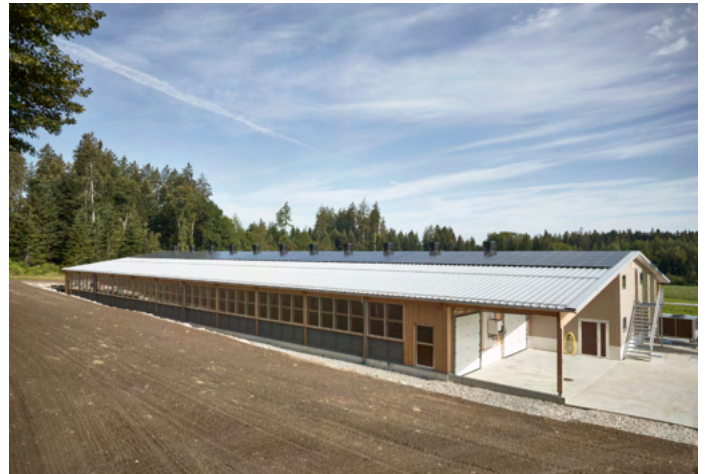
Aussenansicht des Stalls in Zimmerwald mit PV-Dachanlage und verglastem Wintergarten. Rechts neben der Treppe sind Teile der Luft-Wasser-Wärmepumpe zu sehen. Foto: Bell Schweiz AG
