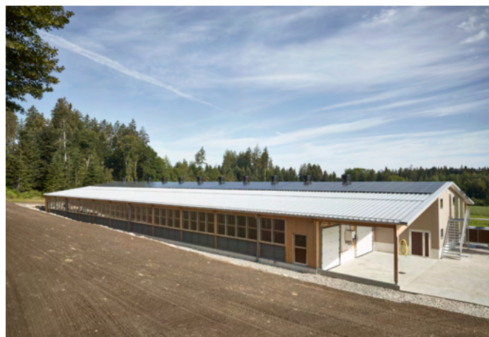
Vue extérieure du poulailler de Zimmerwald avec système de toit PV et jardin d'hiver vitré. A droite de l'escalier, on peut voir des éléments de la pompe à chaleur air/eau. Photo: Bell Suisse SA
